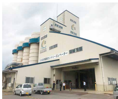
カントリーエレベーター
